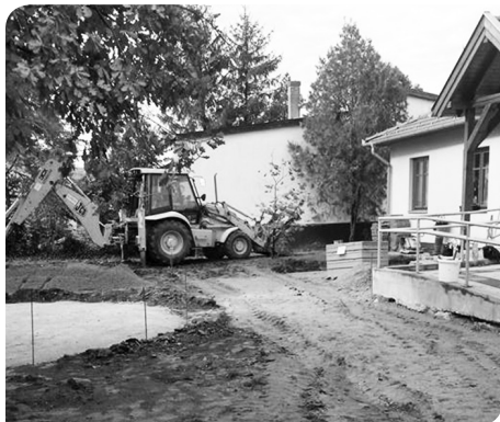
Elkezdődött az óvoda udvar felújítása
